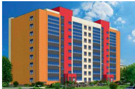
г. Иркутск, ЖК «Жилой дом на Тельмана» Коллекторные узлы отопления 18 шт
