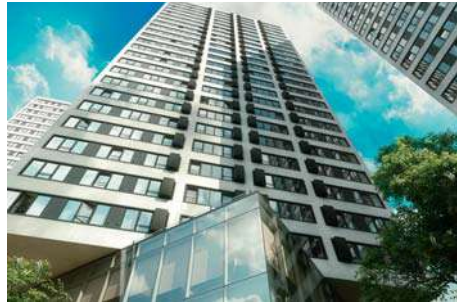
г. Новосибирск, ЖК «Панорама» Счетчики воды с импульсным выходом 656 шт Теплосчетчики с цифровым выходом 326 шт
