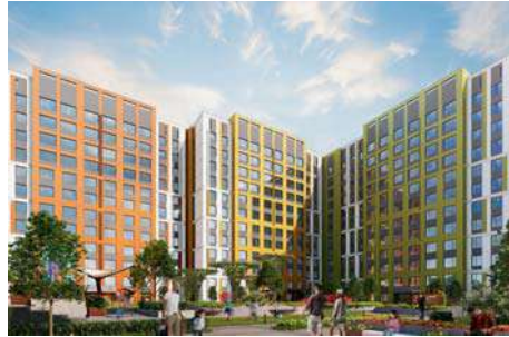
г. Алматы, ЖК «Аманат» Счетчики импульсов 79 шт Теплосчетчики с импульсным выходом 447 шт
