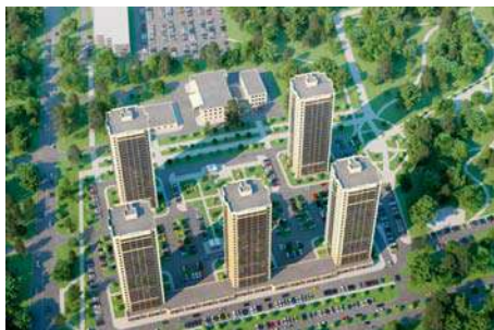
г. Сургут, ЖК «Новые ключи» Коллекторные узлы отопления 25 шт
