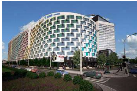
г. Москва, ЖК «Парад Планет» Коллекторные узлы отопления 43 шт
