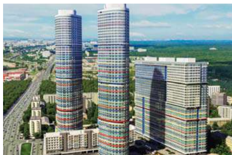
г. Москва, ЖК «Триколор» Теплосчетчики с RS 485 более 1500 шт Счетчики воды с RS 485 более 3000 шт
