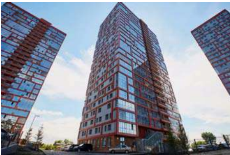
г. Новосибирск, ЖК «Ясный берег» Счетчики воды 608 шт Теплосчетчики с импульсным выходом 276 шт
